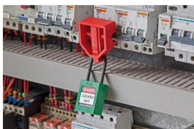
4. Luego de realizar un corte efectivo de todas las fuentes de tensión es importante realizar una verificación de la ausencia de tensión con
